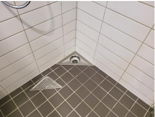
Tettesjiktets tilslutning til sluk - Sluk
