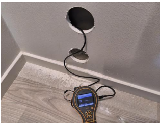
Utført kontroll i tiliggende konstruksjon - Fuktmåling bad 1
