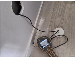
Utført kontroll i tiliggende konstruksjon - Fuktmåling bad 2
