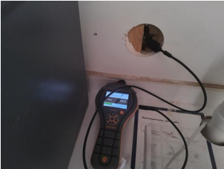
Utført kontroll i tilliggende konstruksjon - Fuktmåling
