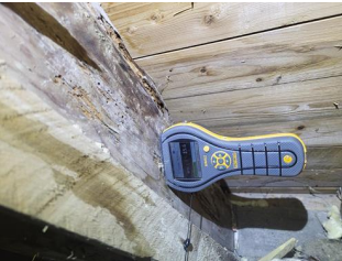
Kontroll i lukkede konstruksjoner ikke utført - Råteskader, fuktmåling og spor etter borrebille 2
