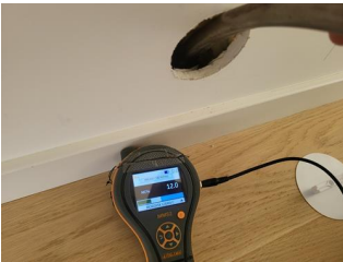
Utført kontroll i tilliggende konstruksjon - Fuktmåling
