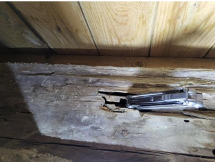
Kontroll i lukkede konstruksjoner ikke utført - Råteskader, fuktmåling og spor etter borrebille 1
