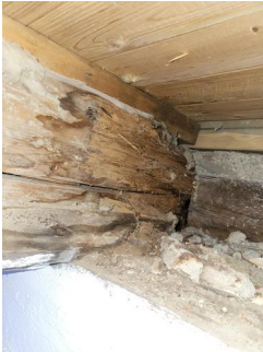
Kontroll i lukkede konstruksjoner ikke utført - Råteskader, fuktmåling og spor etter borrebille 4
