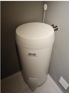
Varmtvannsbereder - VVB
