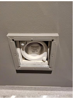
Innvendig stakeluke - Stakeluke i bod og entre.
