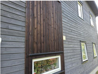
Ytterkledning (fasademateriale, vannbord, utvendig listverk, o.l.) - -
