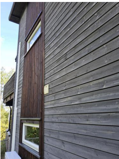
Ytterkledning (fasademateriale, vannbord, utvendig listverk, o.l.) - -
