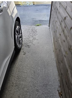
Fundament, grunnmur og gulv mot grunn - Slitasje støpt plate
