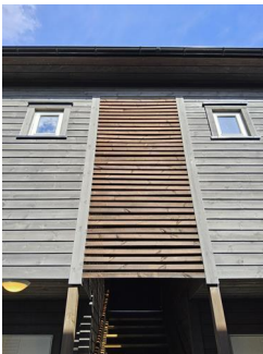
Ytterkledning (fasademateriale, vannbord, utvendig listverk, o.l.) - Spiler mellom vegger ved inngangspartiet
