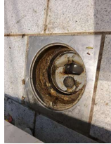
Tettesjiktets tilslutning til sluk - Sluk
