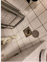
Tettesjiktets tildrning til sluk - Sluk
