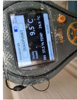
Utført kontroll i tiliggende konstruksjon - Fuktmåling
