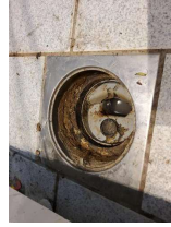
Tettesjiktets tilslutning til sluk - Sluk
