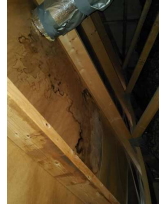
Synlige overflater (takto, vegger, gulv, ol) - Undertak
