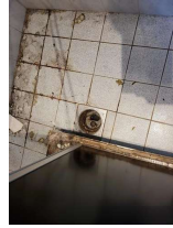
Tettesjiktets tilslutning til sluk - Sluk
