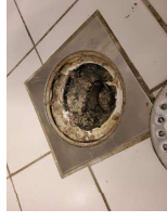
Tettesjiktets tilsjuning til sluk - Sluk
