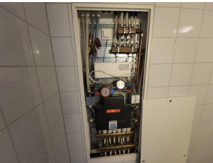
Fordelerskap og fordelerstammer - Fordelerskap for rør-i-rør-systemet, vannbåren gulvvarme, stoppekraner og vannmålere.
