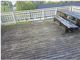
Tilstand på rekkverk og overflatematerialer - .
