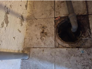
Tettesjiktets tilslutning til sluk - .
