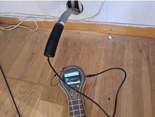
Utført kontroll i tiliggende konstruksjon - .
