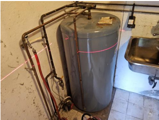
Varmtvannsbereder - .
