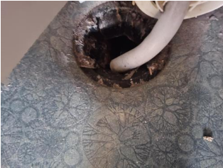
Tettesjiktets tilslutning til sluk - .
