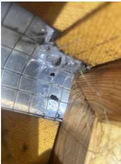
Undertak (inkluderer sløyfer, lekter og innfestninger) - Fuktskjolder og noe uttetheter i møne.
