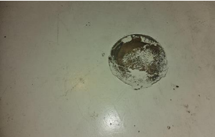
Avløprør (utover det som nevnes under andre sjekkpunkter) - Sluk blendet igjen i bod.
