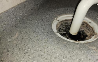
Tettesjiktets tilslutning til sluk - Sluk under badekar.
