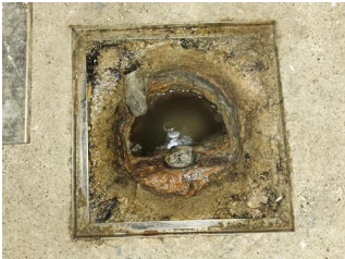
Avløp (inkl. sluk) - Sluk vaskerom
