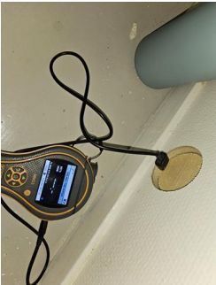
Utført kontroll i tilliggende konstruksjon - Fuktmåling bad
