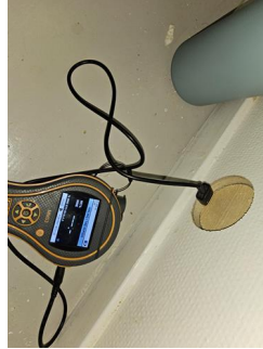
Utført kontroll i tilliggende konstruksjon - Fuktmåling bad
