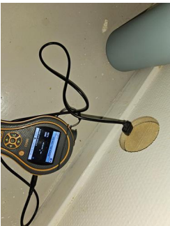
Utført kontroll i tilliggende konstruksjon - Fuktmåling bad
