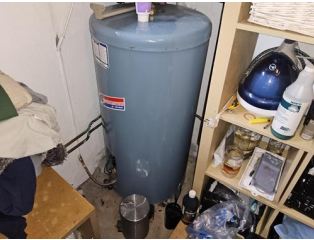
Varmtvannsbereder - Varmtvannsbereder
