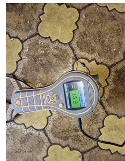
Utført kontroll i tiliggende konstruksjon - Fuktmåling
