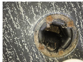
Tettesjiktets tilslutning til sluk - .
