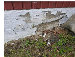
Grunnmur og fundament - .
