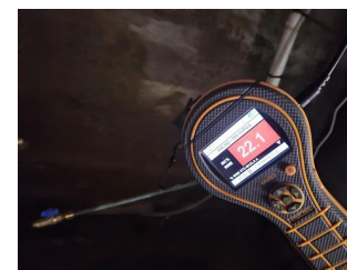
Stikktaking i treverk, fukt og fuktmålinger - Fuktmåling i himling.
