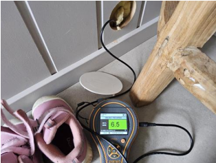
Utført kontroll i tiliggende konstruksjon – Fuktmåling
