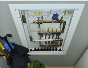
Vannbåren varme (radiatorer, vannbåren gulvvarme, o.l.) - Fordelerskap for vannbåren varmesystem
