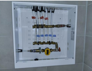
Fordelerskap og fordelerstammer - Fordelerskap for rør-i-rør-systemet
