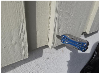
Ytterkledning (fasademateriale, vannbord, utvendig listverk, o.l.) - Eksempel på råteskade
