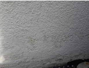
Grunnmur og fundament - -
