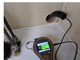
Utført kontroll i tilliggende konstruksjon - Fuktmåling
