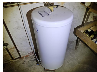
Varmtvannsbereder - Varmtvannsbereder
