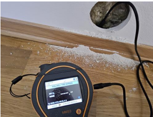
Utført kontroll i tiliggende konstruksjon - Fuktmåling
