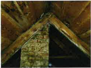
Synlige overflater (taktro, vegger, gulv, o.l) - Fuktmerker i undertak
