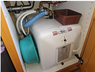
Varmtvannsbereder - Varmtvannsbereder
