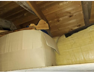
Inspeksjonsmulighet - Ikke tilkomst på uinnredet kaldtloft 2
