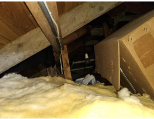
Inspeksjonsmulighet - Ikke tilkomst på uinnredet kaldtloft 1
