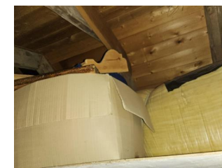
Inspeksjonsmulighet - Ikke tilkomst på uinnredet kaldtloft 2
