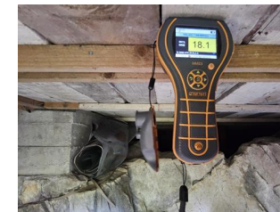
Stikktaking i treverk, fukt og fuktmålinger - Fuktmåling i krypkjeller med luke i grunnmur
