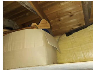
Inspeksjonsmulighet - Ikke tilkomst på uinnredet kaldtloft 2
