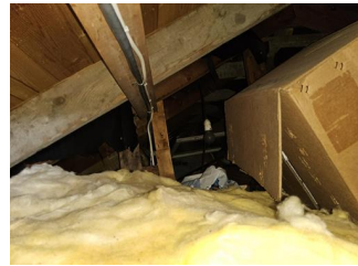
Inspeksjonsmulighet - Ikke tilkomst på uinnredet kaldtloft 1
