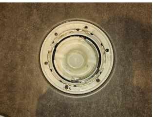
Avløp (inkl. sluk) - Sluk dusjsone
