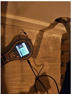
Utført kontroll i tilliggende konstruksjon - Fuktmåling
