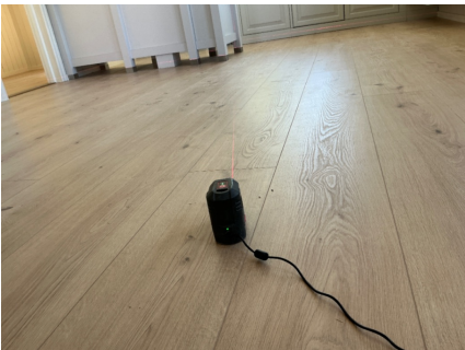
Nivellering stue/kjøkken + soverom, ingen avvik registrert
