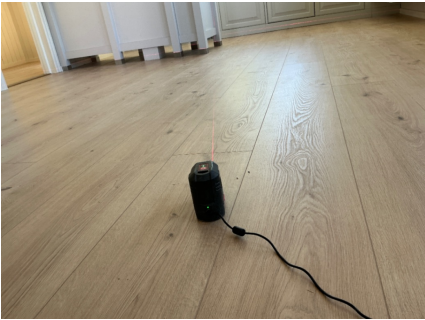
Nivellering stue/kjøkken + soverom, ingen avvik registrert
