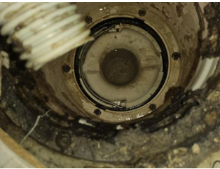
Tettesjiktets tilslutning til sluk - .
