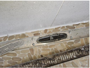
Tettesjiktets tilslutning til sluk - .
