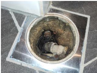
Avløp (inkl. sluk) - Sluk
