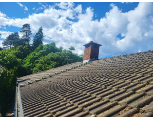
Tekking (med tilhørende beslag) - Taktekking
