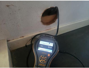
Utført kontroll i tiliggende konstruksjon - Fuktmåling
