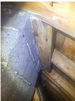
Synlige overflater (taktro, vegger, gulv, o.l) - Fuktmerker ved pipen
