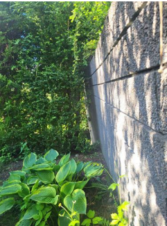
Tilstand - Forstøtningsmur mot øst
