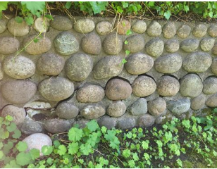
Tilstand - Forstøtningsmur mot syd
