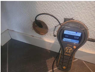
Utført kontroll i tilliggende konstruksjon - Fuktmåling
