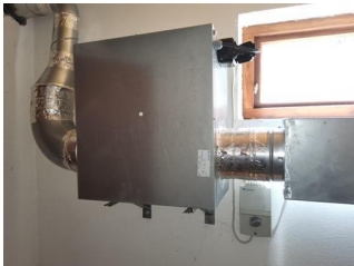
Mekaniske ventilasjonsanlegg (utover det som nevnes under andre sjekkpunkter) - Avtrekksvifte tilkoblet radonbrønn
