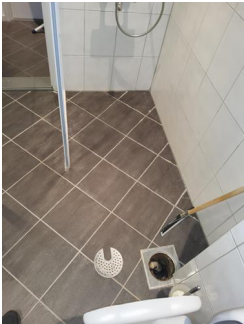
Avløp (inkl. sluk) - Slukets plassering
