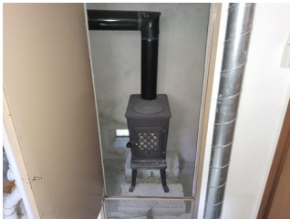
Ildsteder - Vedovn i underetasjen
