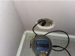
Utført kontroll i tiliggende konstruksjon - Fuktmåling
