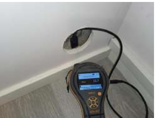
Kontroll i lukkede konstruksjoner - Fuktmåling
