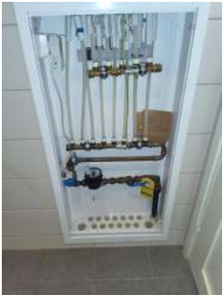
Fordelerskap og fordelerstammer - Fordelerskap for rør-i-rør-system og stoppekran
