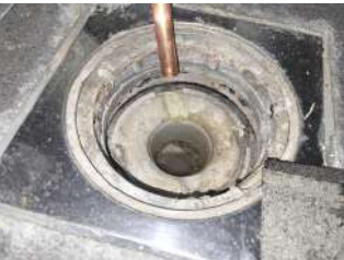
Avløp (inkl. sluk) - Sluk
