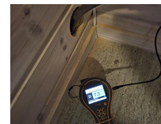
Utført kontroll i tilliggende konstruksjon - Fuktmåling
