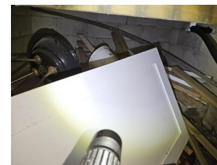
Inspeksjonsmulighet - Eksempel på lagrede materialer og gjenstander i krypekjeller
