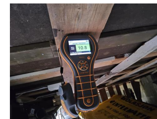
Stikktaking i treverk, fukt og fuktmålinger - Fuktmåling krypekjeller
