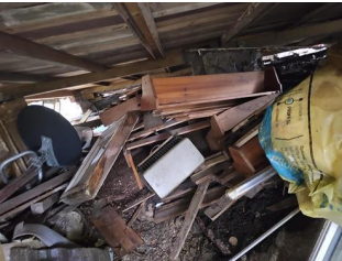
Inspeksjonsmulighet - Lagrede gjenstander og løsøre i krypekjeller under hytte 1
