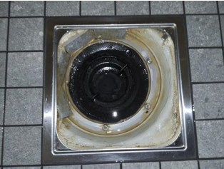
Avløp (inkl. sluk) - Sluk
