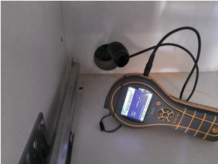
Utført kontroll i tilliggende konstruksjon - Fuktmåling
