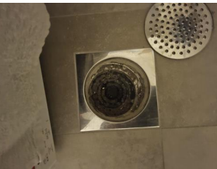
Tettesjiktets tilslutning til sluk - .
