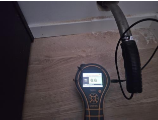
Utført kontroll i tiliggende konstruksjon - .
