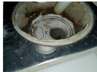
Tettesjiktets tilslutning til sluk - Sluk
