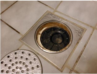
Tettesjiktets tilslutning til sluk - Sluk
