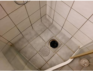
Tettesjiktets tilslutning til sluk - Sluk
