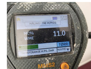
Overflate himling - Fuktmåling
