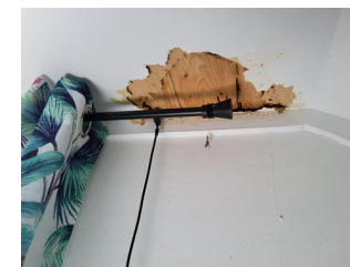
Overflate himling - Himlingsflater i soverom- 2.etasje
