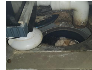
Tettesjiktets tilslutning til sluk - Sluk
