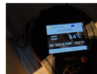
Kontroll i lukkede konstruksjoner - Fuktmåling
