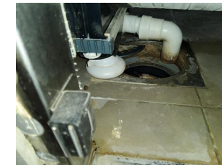
Tettesjiktets tilslutning til sluk - Sluk
