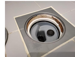
Tettesjiktets tilslutning til sluk - Sluk
