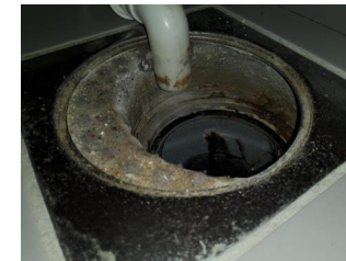
Tettesjiktets tilslutning til sluk - Sluk
