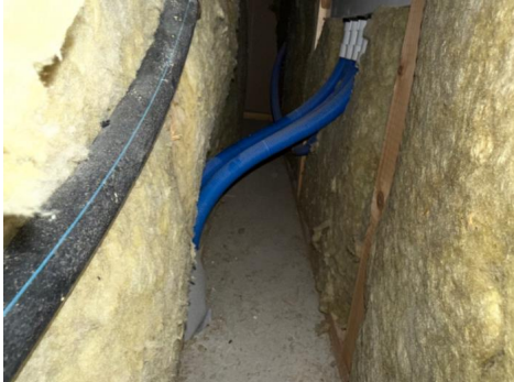
Innvendig sjakt mellom kjøkken og bad
