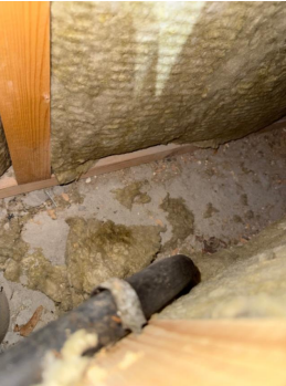
Innvendig sjakt mellom kjøkken og bad
