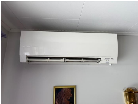
Luft-til-luft varmepumpe innedel
