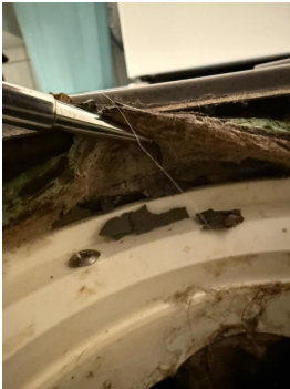
Hull i mansjett/membran ved sluk
