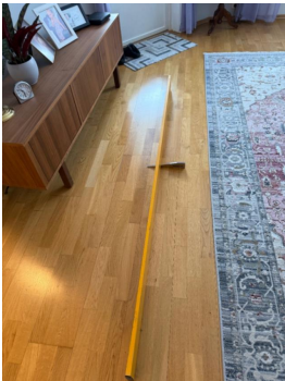
Måling av høydeforskjeller med rettholt og kile
