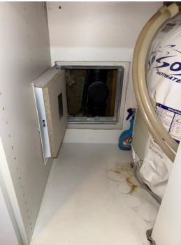
Inspeksjonsluke til sjakt mellom kjøkken og bad
