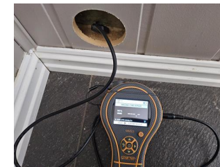
Utført kontroll i tilliggende konstruksjon - Fuktfuktmåling bad hybel
