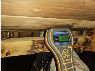
Synlige overflater (taktro, vegger, gulv, o.l) - fuktmåling.
