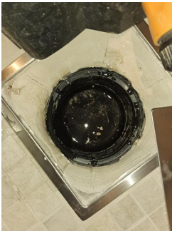
Tettesjiktets tilslutning til sluk - .
