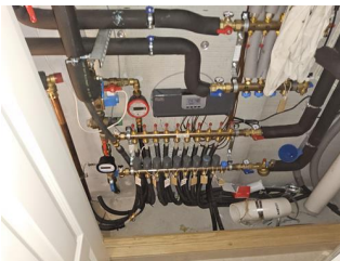
Vannbåren varme (radiatorer, vannbåren gulvvarme, o.l.) - Fordelerstokk plassert i teknisk rom.
