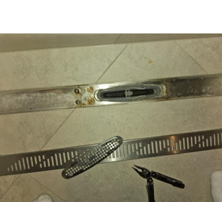
Tettesjiktets tilslutning til sluk - i dusj
