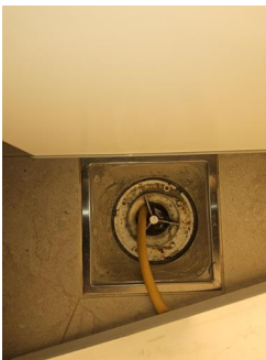
Tettesjiktets tilslutning til sluk - .
