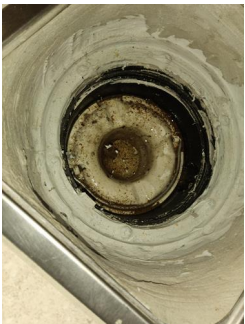
Tettesjiktets tilslutning til sluk - .
