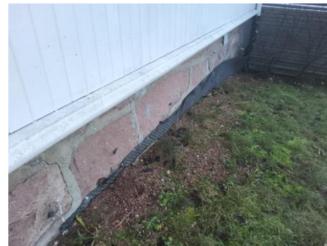
Fuktsikring av grunnmur - [Grunnmursplast uten topplist. ]
