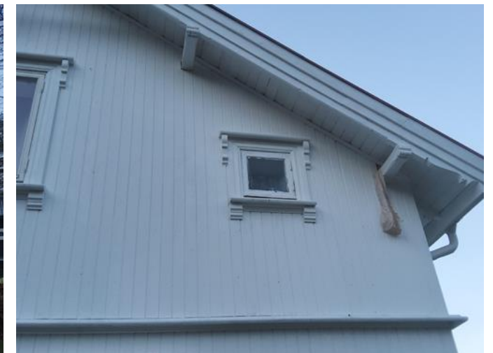
Annet - [Eksempel på vindu med ett-lags glass i 2.etasje. ]
