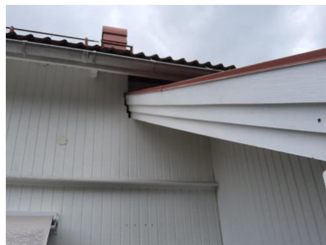
Yttervegger inkl. fasader og konstruksjon - [Avslutning av utfored yttervegg mot tilbygg. ]
