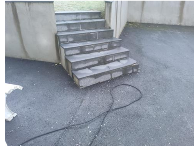
Utvendige trapper - [Trapp ved støttemur ved garasje ]
