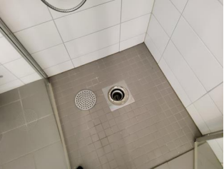
Tettesjiktets tilslutning til sluk - Sluk 1
