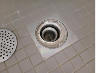
Tettesjiktets tilslutning til sluk - Sluk 2
