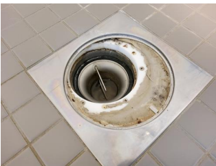
Tettesjiktets tilslutning til sluk - Sluk 1
