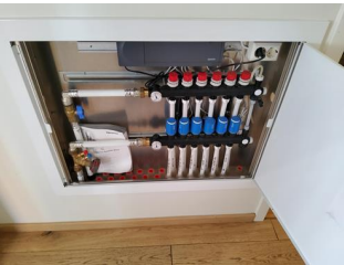
Vannrør (utover det som nevnes under andre sjekkpunkter) - Fordelerskap, ventilasjonsaggregat og røropplegg i benkeskap 2
