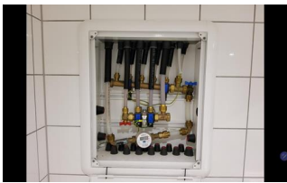
Fordelerskap og fordelerstammer - FordeFordelerskap for rør-i-rør-systemet
