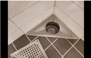
Tettesjiktets tilslutning til sluk - Sluk
