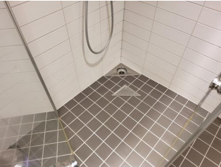
Tettesjiktets tilslutning til sluk - Sluk
