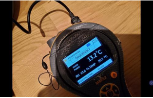
Utført kontroll i tiliggende konstruksjon - Fuktmåling
