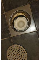
Tettesjiktets tildutning til sluk - Sluk i dusjsonen.
