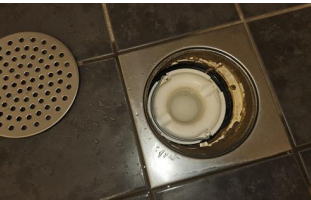
Tettesjiktets tilslutning til sluk - Sluk i dusjonen.
