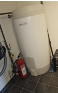
Varmtvannsbereder - Varmtvannsbereder.
