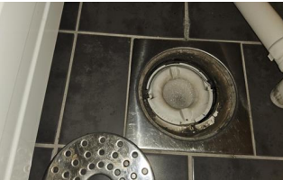
Tettesjiktets tilslutning til sluk - Sluk på vaskerom.
