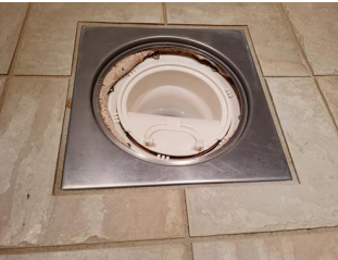
Tettesjiktets tilslutning til sluk - Sluk
