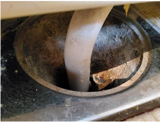
Tettesjiktets tilslutning til sluk - Sluk
