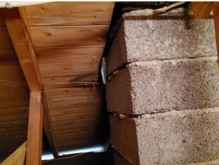
Synlige overflater (taktro, vegger, gulv, o.l) - Fuktmerker ved pipe
