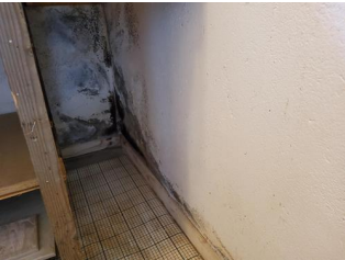
Overflate vegg - Veggflater i bod ved vaskerom
