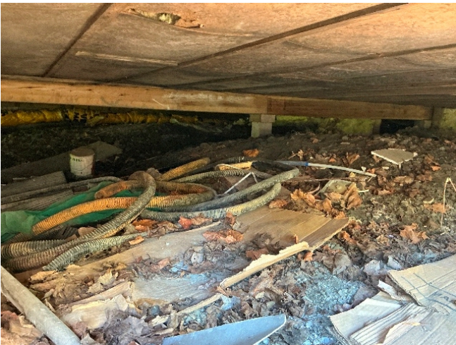
Bilde av gulv fra undersiden
