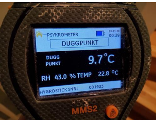
Utført kontroll i tiliggende konstruksjon - Fuktmåling
