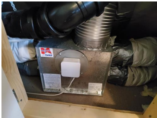
Mekaniske ventilasjonsanlegg (utover det som nevnes under andre sjekkpunkter) - Ventilasjonsaggregat
