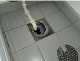
Tettesjiktets tilslutning til sluk - Sluk
