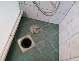
Tettesjiktets tilslutning til sluk - Sluk
