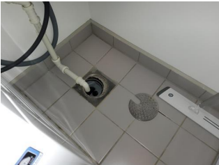
Tettesjiktets tilslutning til sluk - Sluk
