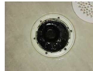
Tettesjiktets tilslutning til sluk - Sluk
