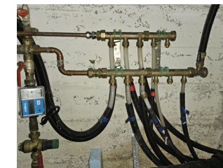
Fordelerskap og fordelerstammer - Fordelerstammer for rør-i-rør-systemet
