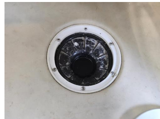
Tettesjiktets tilslutning til sluk - Sluk
